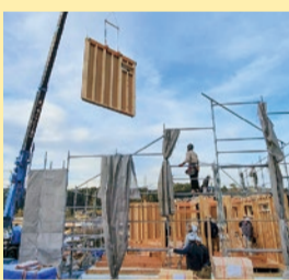
パネル化により工期の短縮と大工仕事の省力化ができます
