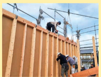
大型パネルは、在来軸組み工法を応用しているため、初めての大型でも取り組みます
