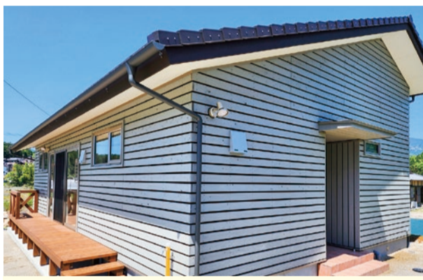
夏の外壁の日射遮蔽効果がある、すのこ状の外壁
