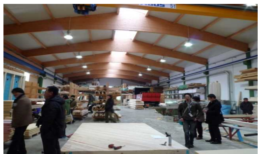
↑大断面集成材の梁が掛けられた作業場
