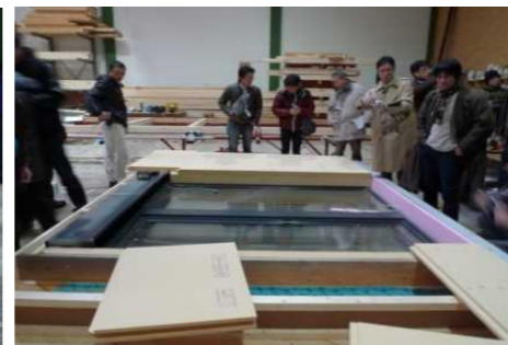
↑施工中のパネル
