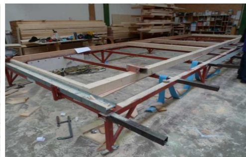
↑パネル製作の台
