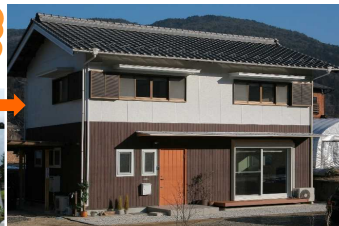
↑外観はお施主様の御希望イメージ通りに。2階の外壁・底は塗替えのみです。
