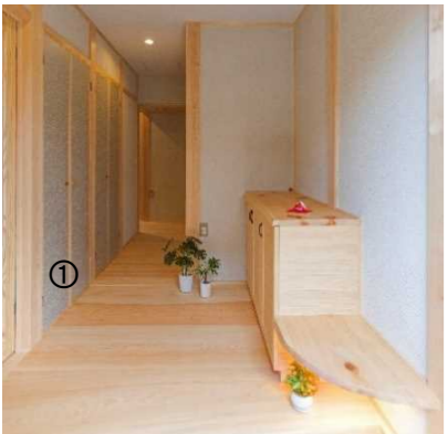
↑右写真引戸横のFIXガラスで明るい玄関ホール。6mm鉄板補強のベンチに座られて靴の着脱をされます。
