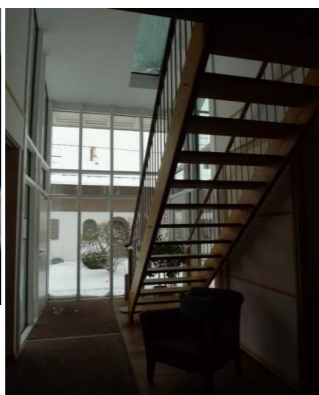
↑ 開口部が大きいサッシがトリプルで高性能。シャワーとトイレ、2階階段室は↑ 日本人にも違和感のないデザインで、収納や可動式家具による間仕切り等、多くの工夫がされており、断熱材や塗料等、自然素材の利用もアピールしている。開口部が大きいのに、外は-5℃でも結露していない。開口部のU値が0.8W/㎡K位になるといろいろできる。
