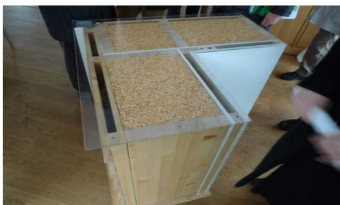
↑ 大鋸屑断熱材は290mm、U値0.18W/㎡K、内壁側の空間は配線スペース。
