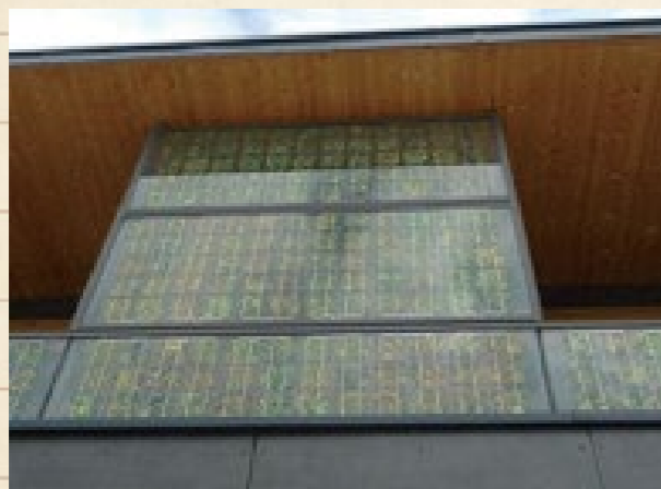
↑2階のバルコニーに設置された太陽光発電パネル。どの展示住宅も暖房、給湯、調理、家電の全てのエネルギーを効率良く省エネにしているか、建築資材が環境に優しいかを主張している。
