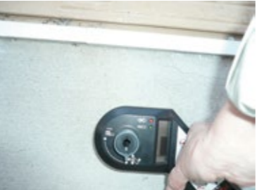
既設基礎に鉄筋が入っているか調べる道具の配筋チェッカー(ドイツ製)幸いにも鉄筋が入っていました。
