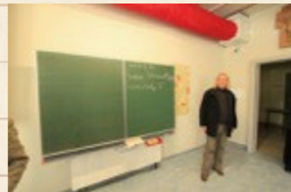
↑案内役のガイグ氏と天井の赤いパイプは吸気ダクト
