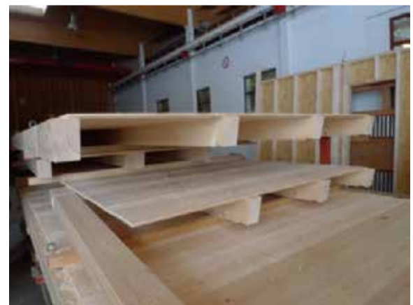
屋根パネルの製作途中
