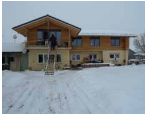
2階増築工事現場の外観
