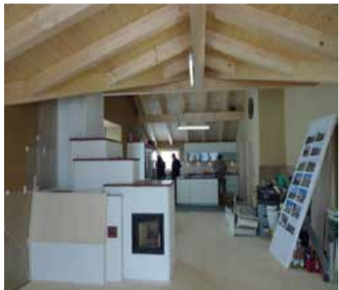
内部は土壁ボード20mmに、中塗り6mm+仕上げ塗り1mm
