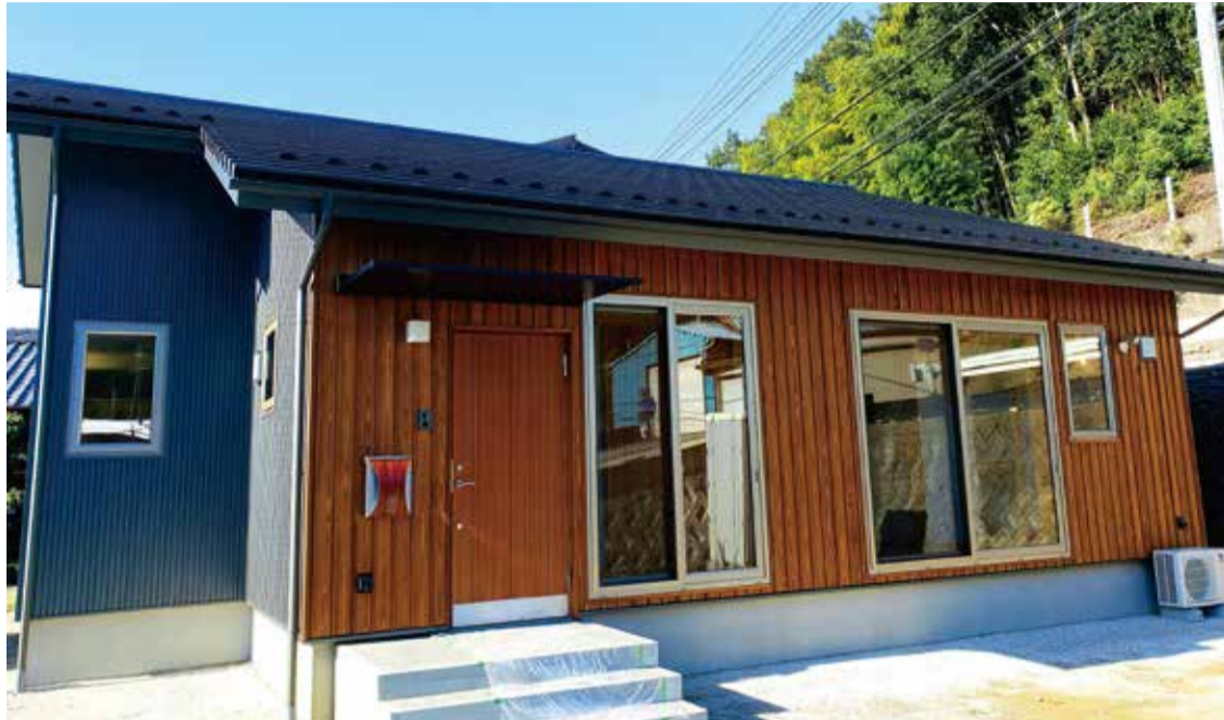
外観。外壁の一部を板貼にして押え縁仕上げにすることで立体感ができ、ガルバの角波にマッチします。
