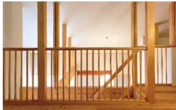
ロフトの手摺格子。腰壁を格子にすることで空間が広く感じられます。
