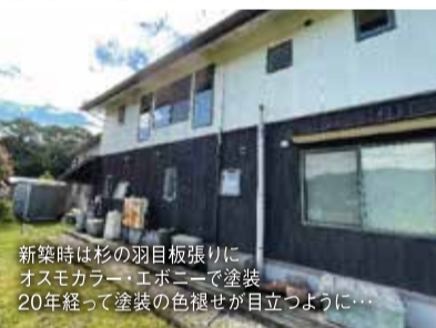
新築時は杉の羽目板張りにオスモカラー・エボニーで塗装。20年経って塗装の色褪せが目立つように…
