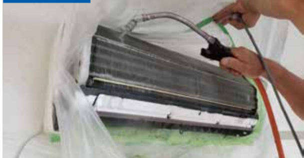
しっかりと養生し、電装部分やお部屋に水が漏れないようにし高圧洗浄します
