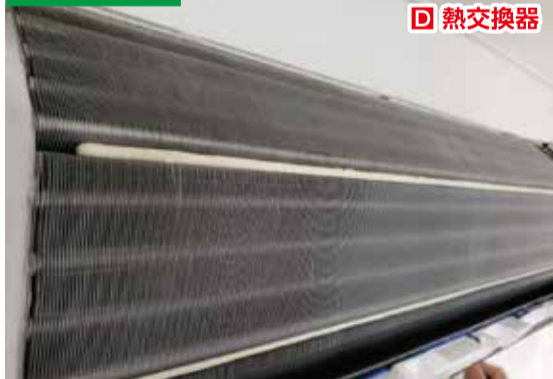
しっかりと養生し、電装部分やお部屋に水が漏れないようにし高圧洗浄します
