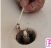
おお〜と〜!排水口内部もめちゃ汚れています。シャフトに髪の毛が巻き付いています。つまようじや綿棒で汚れを取りスポンジで洗い流します。
