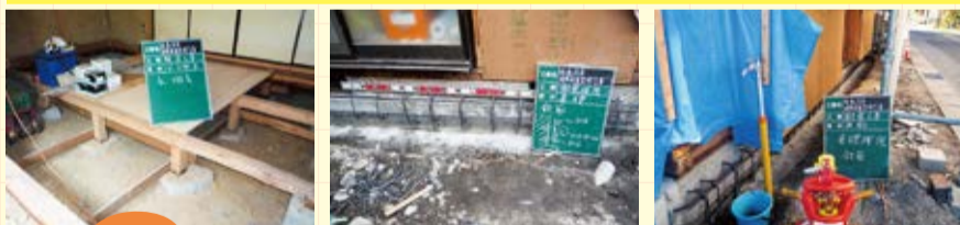
無筋基礎だったため 外周部基礎補強、外壁はハイベストウッズの耐力壁
