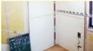
耐震改修パネルで壁の補強
