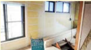
壁内充填断熱WG/16k 厚100ミリ
