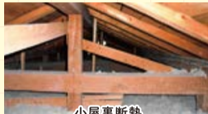
小屋裏断熱 セルロースファイバーブローイング厚300ミリ
