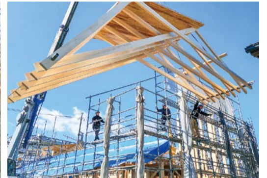
10組程のトラスを先組みし、そのまま吊り上げて設置します。
