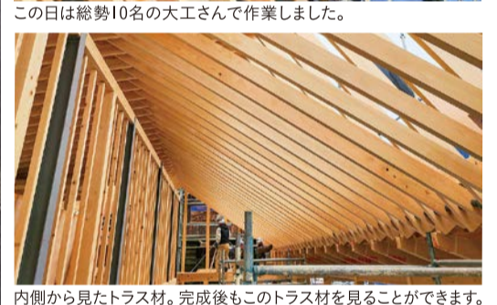
内側から見たトラス材。完成後もこのトラス材を見ることができます。
