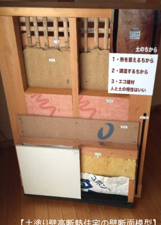
【土塗り壁高断熱住宅の壁断面模型】
