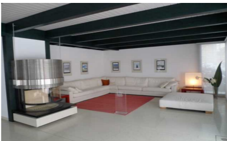
↑ガラス張り(トリプルLow-eアルゴン、U値0.8W/m 2 K)木造ラーメン構造。↑
