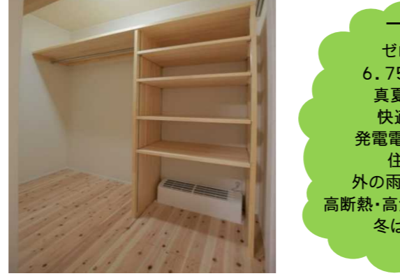
メンテナンス性の高い床下エアコン。↓この8帖用1台で、71帖全室の暖房を行います。
