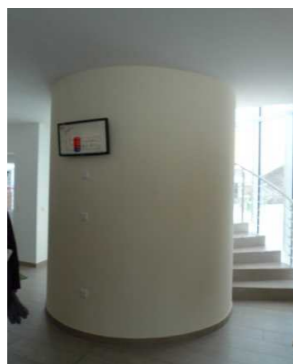
←7.0m 3 の貯湯槽
