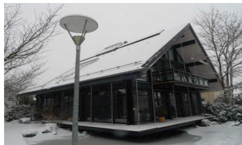
↑ガラス張り(トリプルLow-eアルゴン、U値0.8W/m 2 K)木造ラーメン構造。↑
