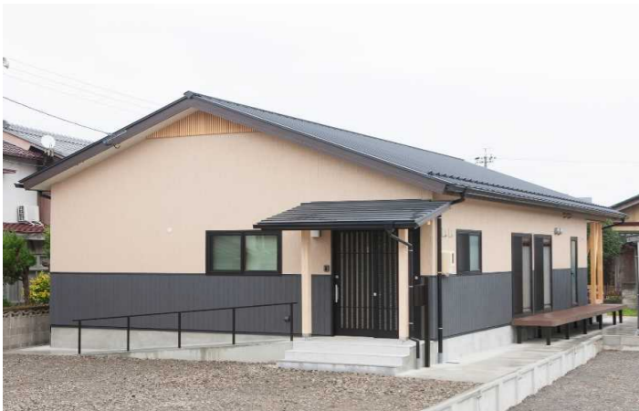
↑貼り分けした腰部分がアクセントとなって、落ち着いた外観。屋根の頂点は通常、建物の幅の真中としますが、荷重の伝わり方も考慮した位置としましたので、少し『へ』の字になっています。
