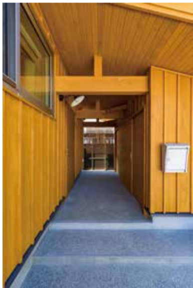
この通路の左側が玄関、 右側が外部収納です。
